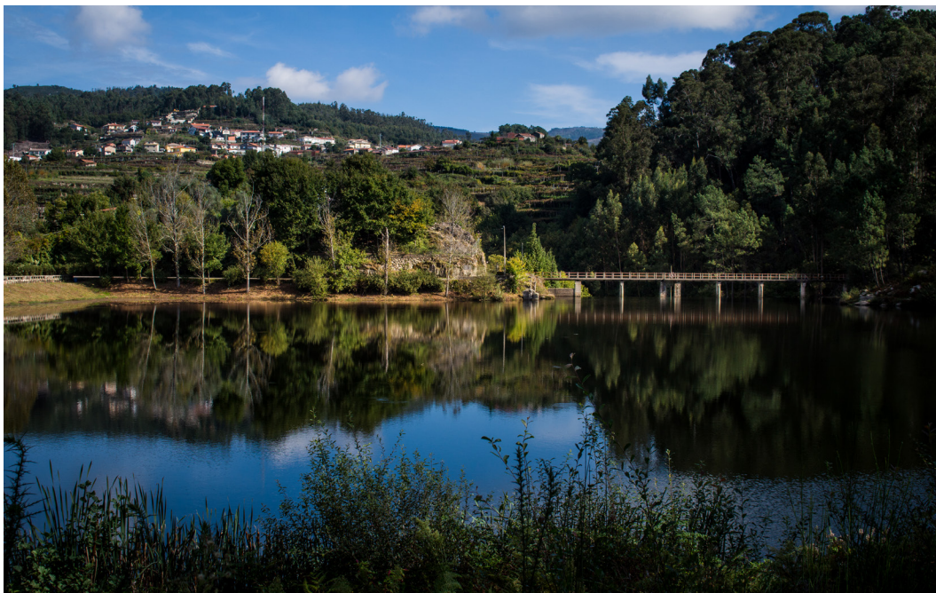
Vale de Cambra – Barragem Eng. Duarte Pacheco.
